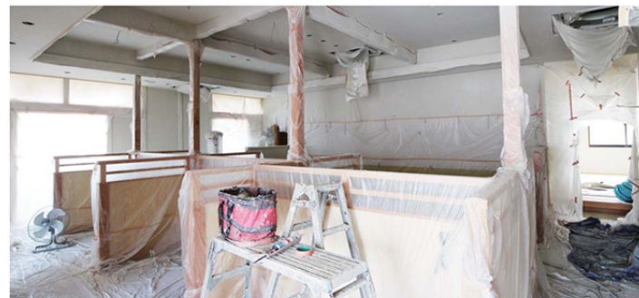
(図VII) 現場内観。残念ながら養生外すのはこの写真撮った数時間後。大阪展セミナーにて出来上りを披露致します。
